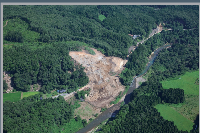
磐井川（上流）土砂崩れ（2008 年）
