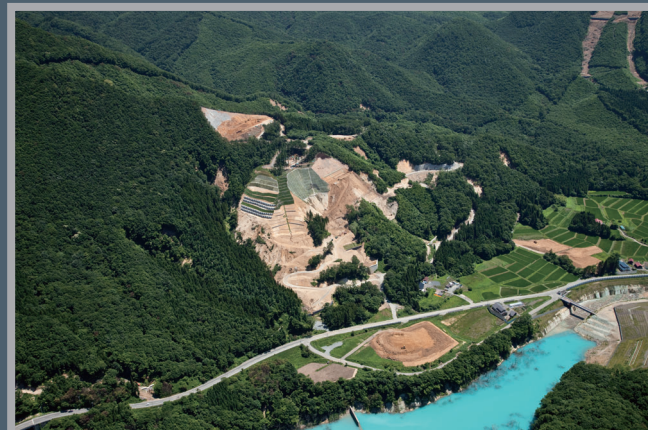
磐井川土砂崩れ復旧工事（2011 年）
